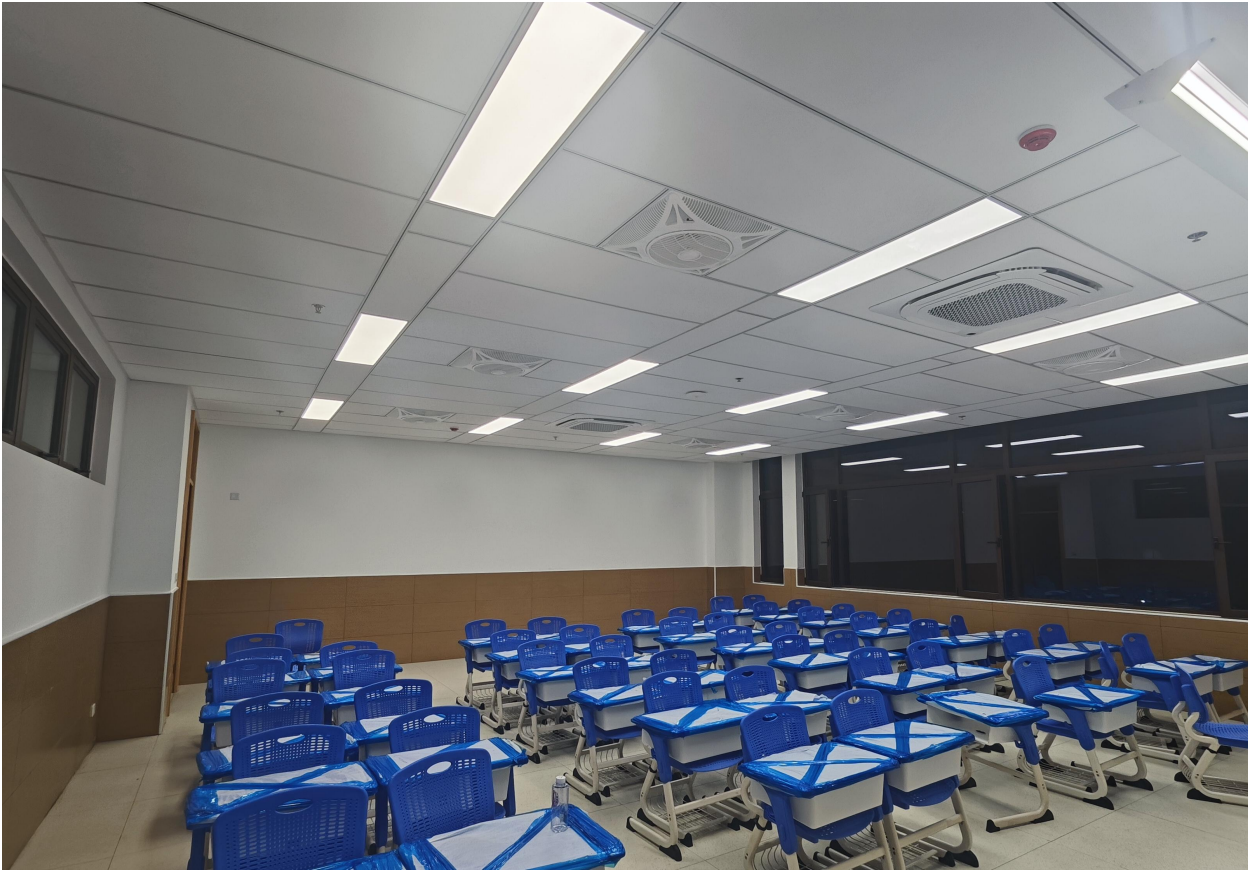
照片1 教室灯具布灯方式照片
